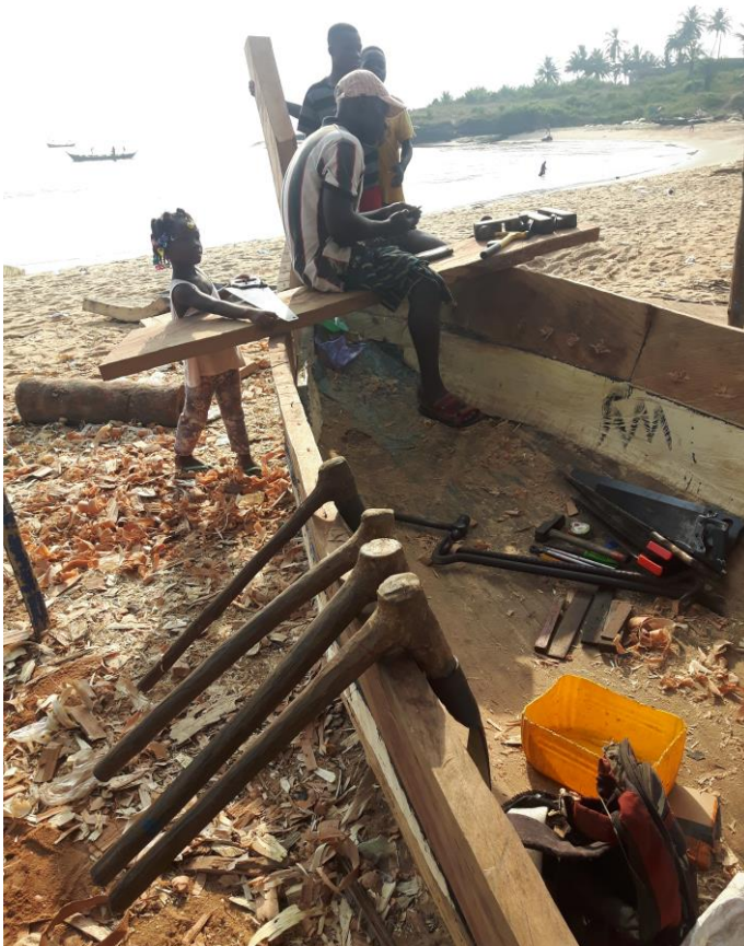
Die Pirogge wird repariert
