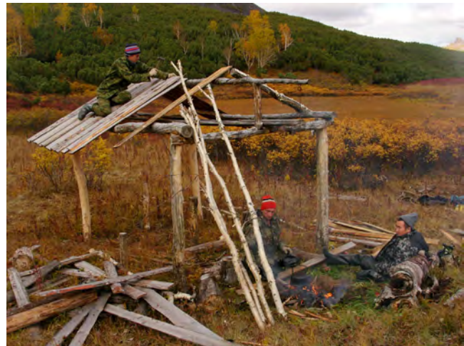
Bau eines Unterstandes
