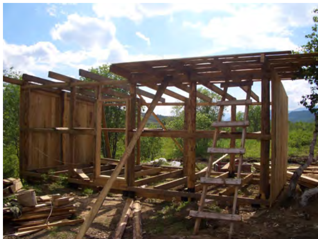
Dusche im Werden
